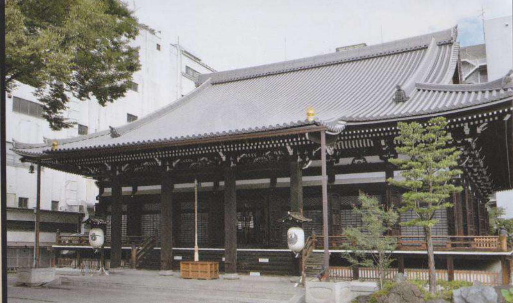
Le temple principal conçu par l'ingénieur Shunichi Amanuna. Il réunit les meilleurs matériaux et techniques que l'époque Muromachi (1392-1573) avait à offrir. Le temple fut construit en bois de zelkova. Superficie totale : 587.4m 2
